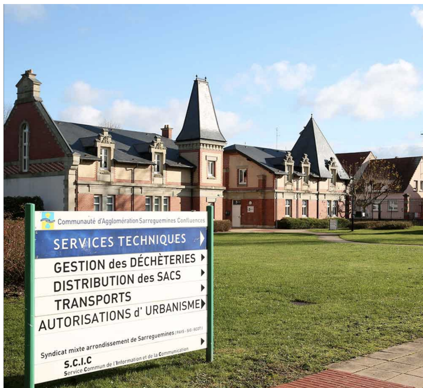
FIGURE 2 – Bâtiment du service informatique de la CASC à Sarreguemines. Source : Créé par l’auteur.
